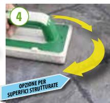
④ **Pulizia con feltro abrasivo per superfici strutturate:** per superfici più strutturate, eseguire la pulizia quando lo stucco è ancora fresco utilizzando un feltro inumidito con acqua della vaschetta ①. Agire in senso rotatorio per emulsionare lo stucco sulle piastrelle e rifinire le fughe. Raccogliere con la spugna l'emulsione formatasi sulle piastrelle.
